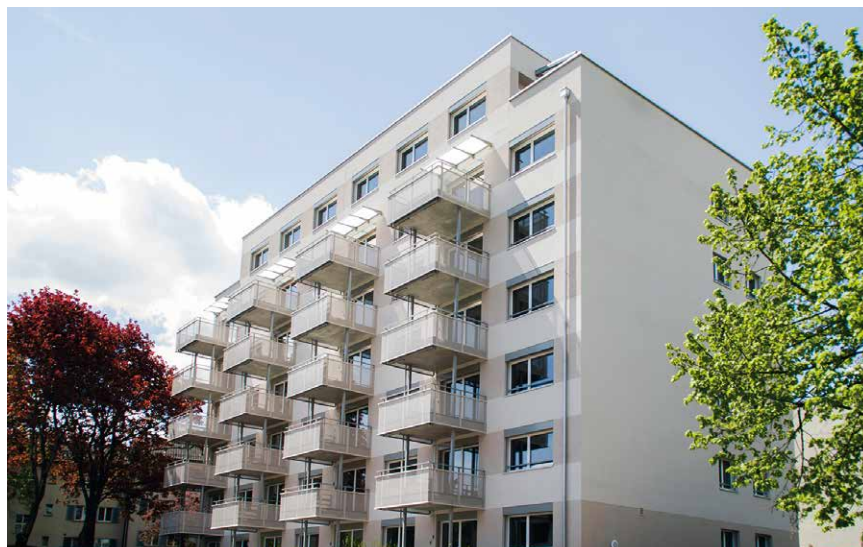
Umgebaute Scheune und Bauernhaus in Ebertswil, oben, Mehrfamilienhaus mit 26 Wohnungen am Eulenweg in Zürich Altstetten, unten
